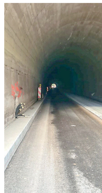
• Lavori di manutenzione in val d'Ega
